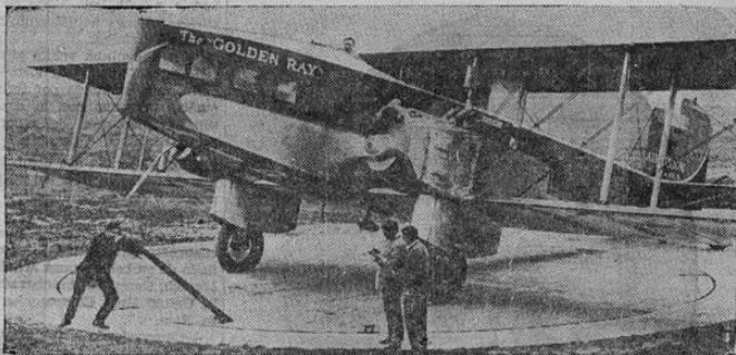
En el aeródromo de Croydon, Inglaterra, se ha instalado una mesa giratoria para aeroplanos similar a la usada en los ferrocarriles. Se usa para chequear debidamente los compases de los aparatos
